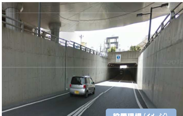
設置現場 (イメージ)
