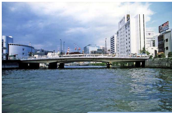
設置現場 (イメージ)
